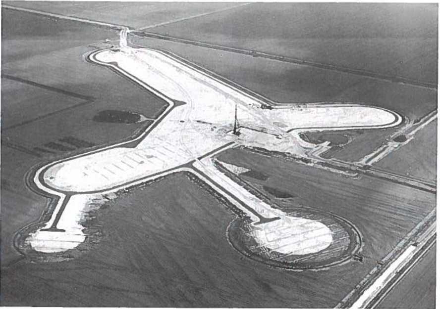
afb. 16. 1982. De contouren van het terrein voor het nieuwe KG-zendstation zijn bepaald; een weg naar alle werkterreinen is aangelegd. De voorbereidingen voor de bouw van een modern zendstation, waartoe ook een immens antennepark zal behoren, zijn getroffen. In 1985 konden er al proefuitzendingen plaatsvinden.
